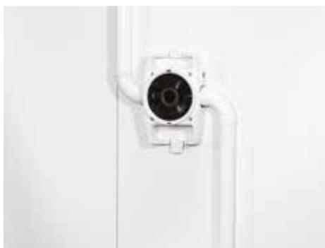
Sella di appoggio a muro con raccordo aerraulico diametro 51 mm
